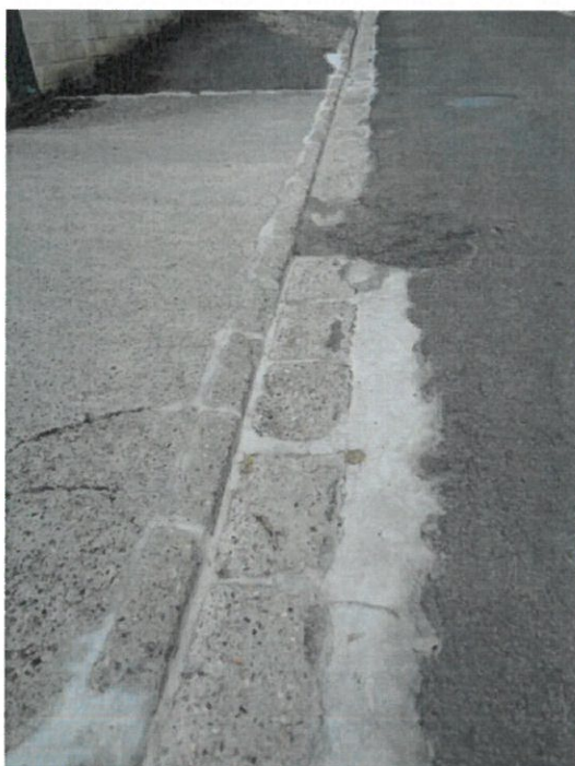
Figure 3 : Caniveau re-jointé (FREDON de Picardie)
